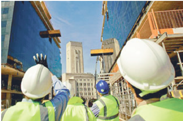
Выполнение функций технического заказчика
